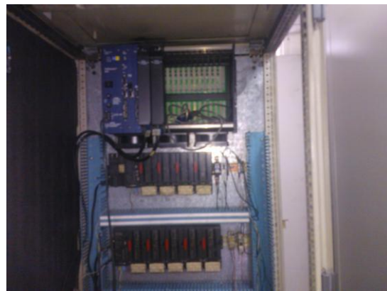
Fig. 1. Sistema de control basado en PLC
